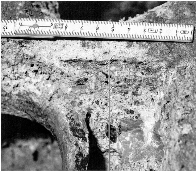
Abb. 16. Schaffhausen, Zur Oberen Tanne . Nische in Keller B. Topf 18 nach der Sondierung auf der Südseite des Randes. 1 Zementmörtel; 2 Kalkmörtel; 3 Topfrand. Foto/Grafik G. Faccani, Zürich.
