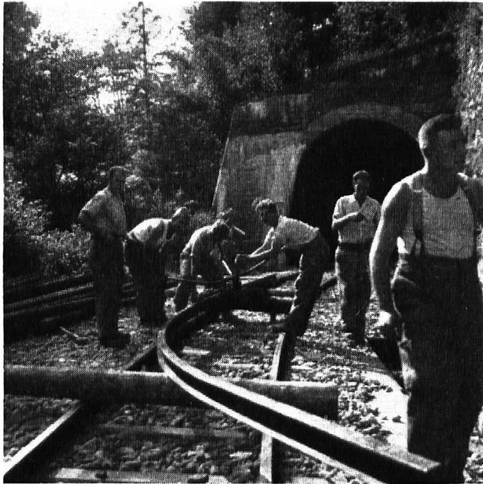
Das Biegen der Schienen für die Kurven
