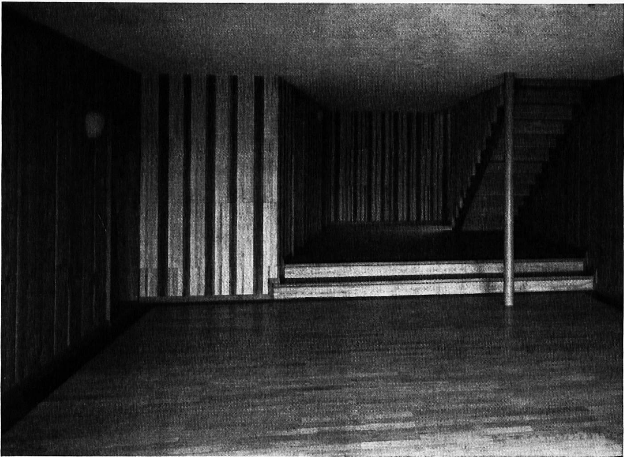
Treppenhalle in der Forstwirtschaftlichen Zentralstelle in Solothurn. Seitenwände aus astigen Lärchenbrettern. Hinterwand aus unregelmäßigen Streifen verschiedener Hölzer. Arch. Steiger, St. Gallen, Innenarch. J. Müller, Zürich. Photo Brandt, Solothurn.
