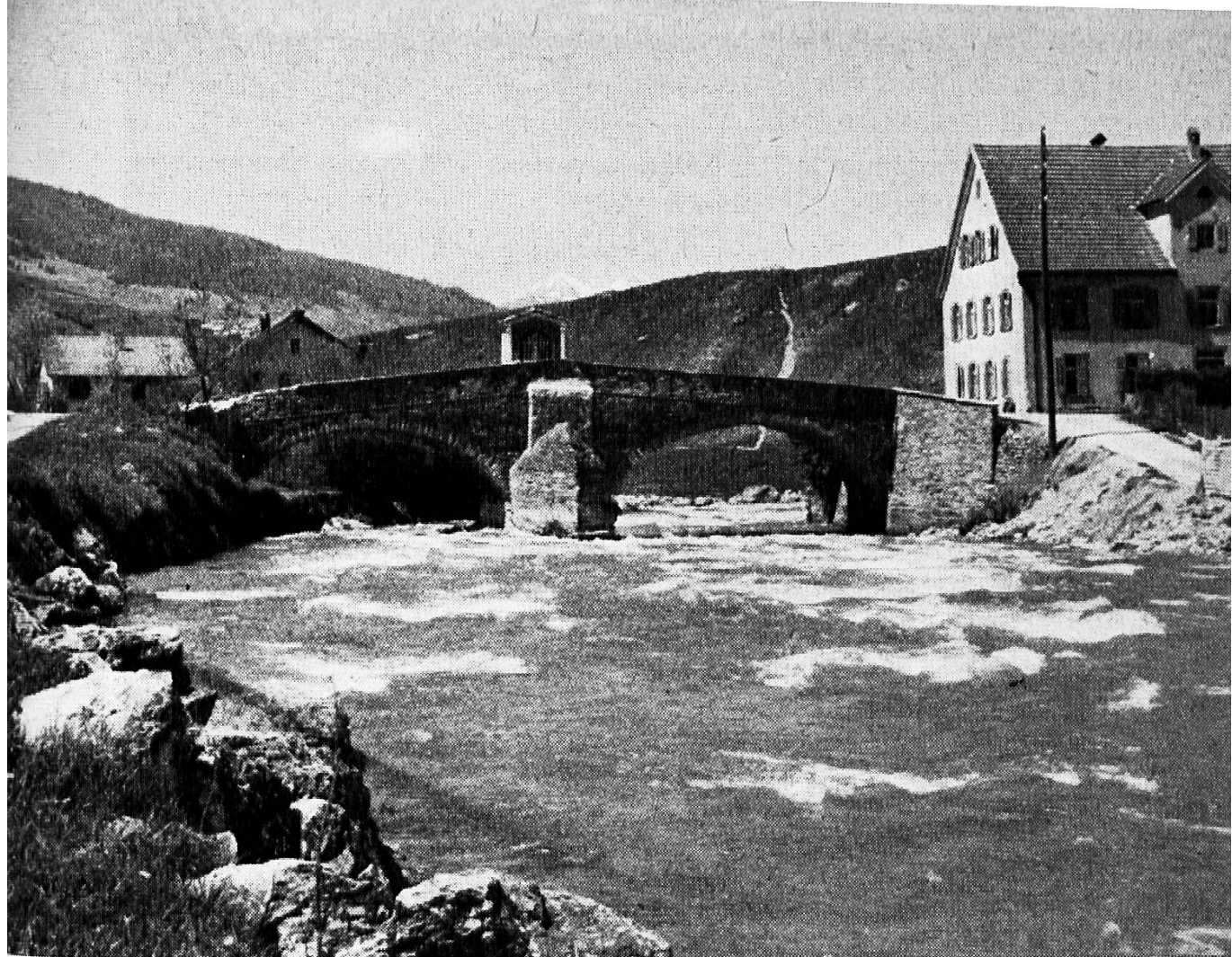
Savognin: Die alte Steinbrücke verbindet die beiden Dorfteile links und rechts der Julia. Sie gehört zum Ortsbild.
