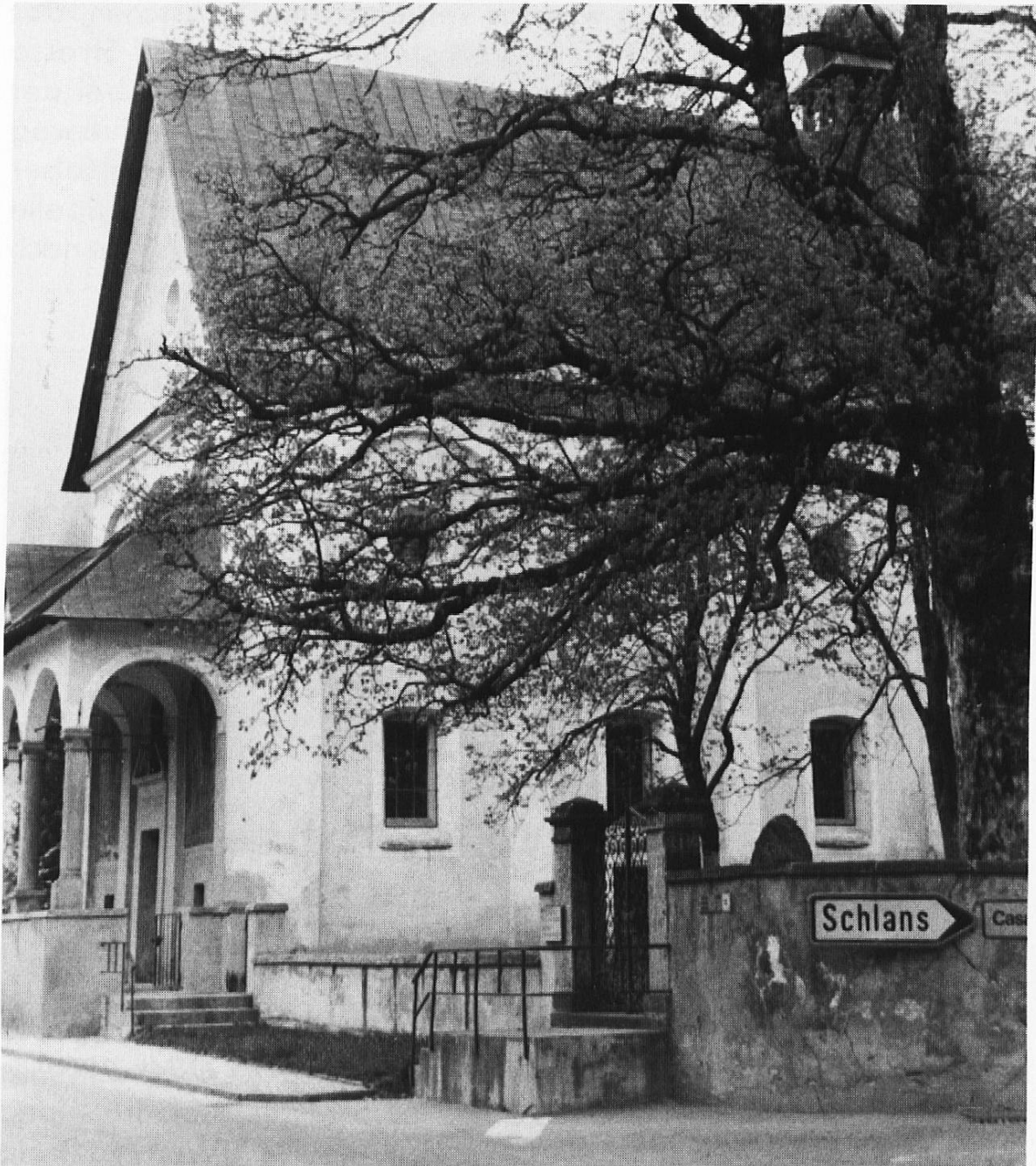
Bei der Kapelle S. Onna in Trun wurde 1424 der Graue Bund geschworen
