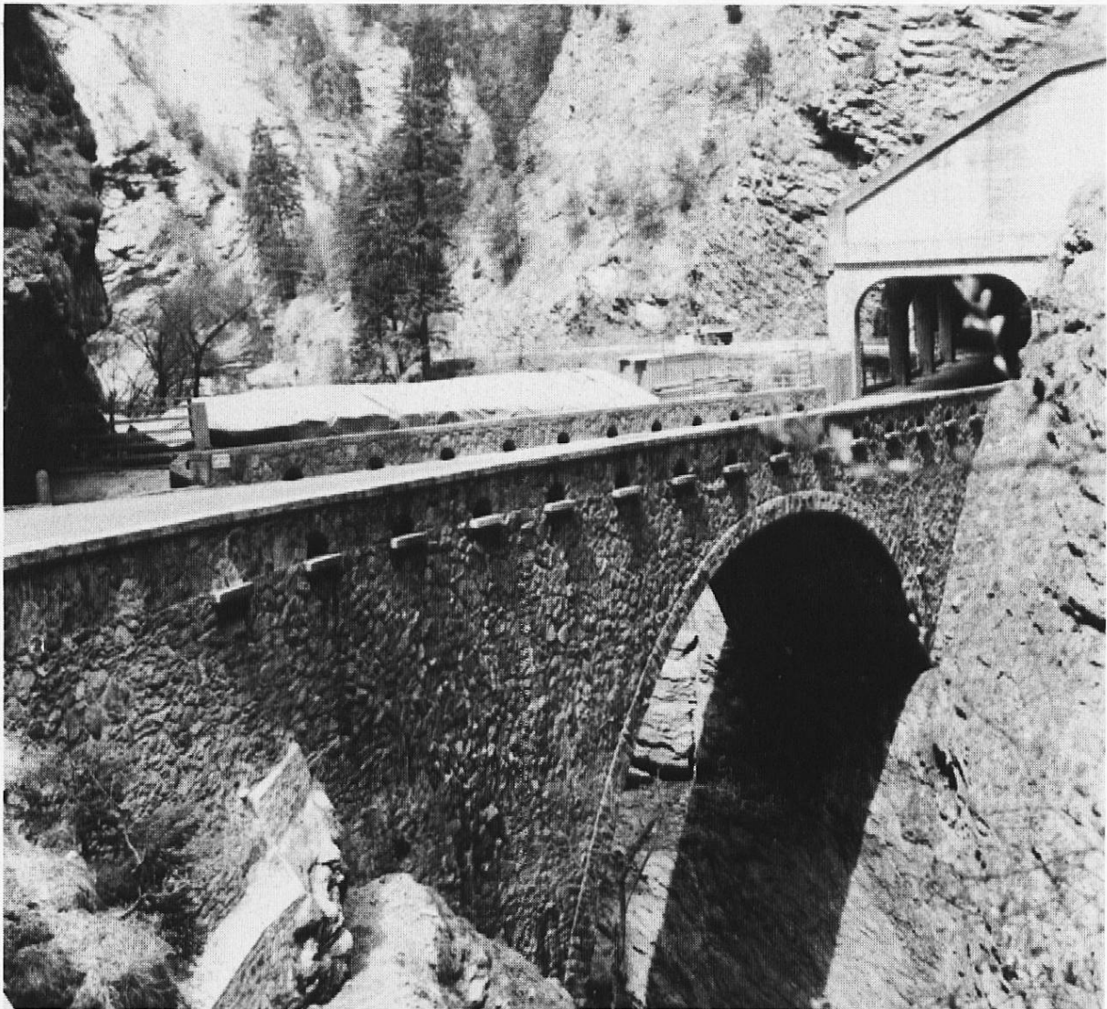
Brücke der Kantonsstrasse mit Galerie in der Viamala-Schlucht. Neben der Strassenbrücke die alte Wildener-Brücke aus dem Jahre 1738 (zugedeckt, in Renovation)
