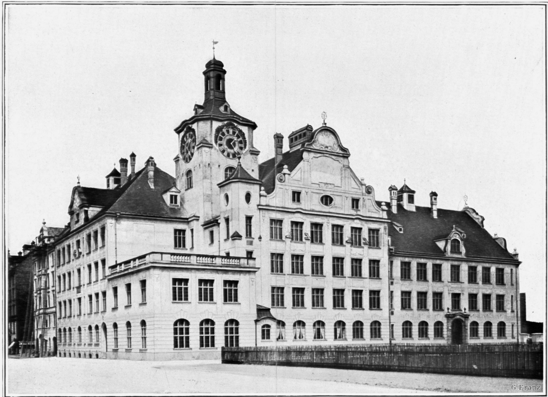
Schulhaus an der Weilerstrasse in München. Ansicht von Süd-Westen.
