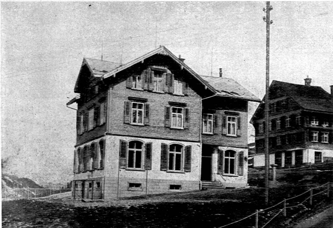
Schulhaus kath. Stein
