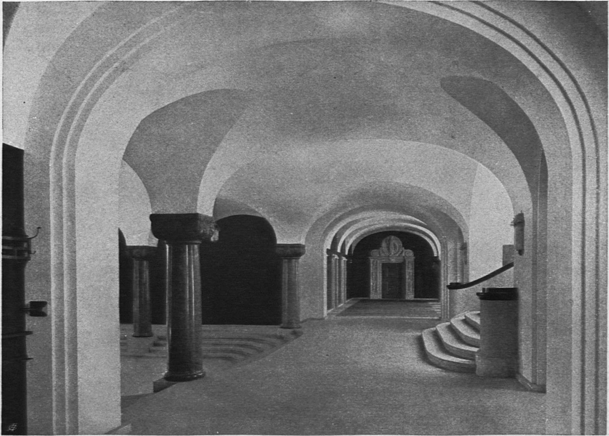
Vestibül im Kollegiengebäude, Eingang von der Rämistrasse
