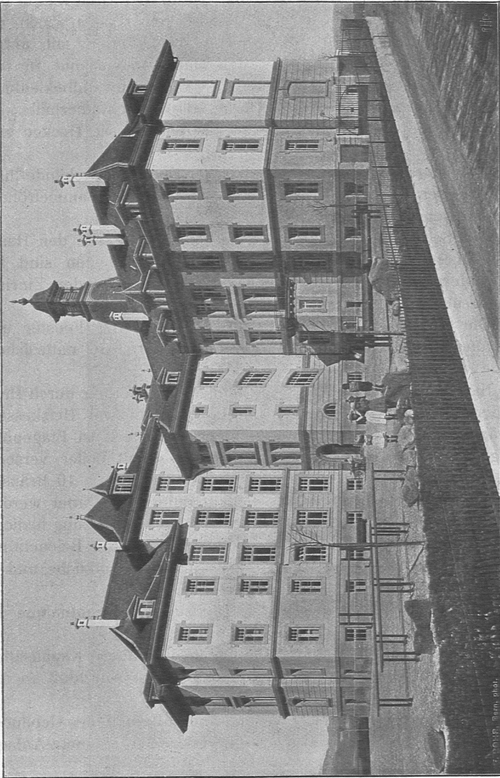
Schofhalde-Schulhaus in Bern. — West- und Nordfassaden.
