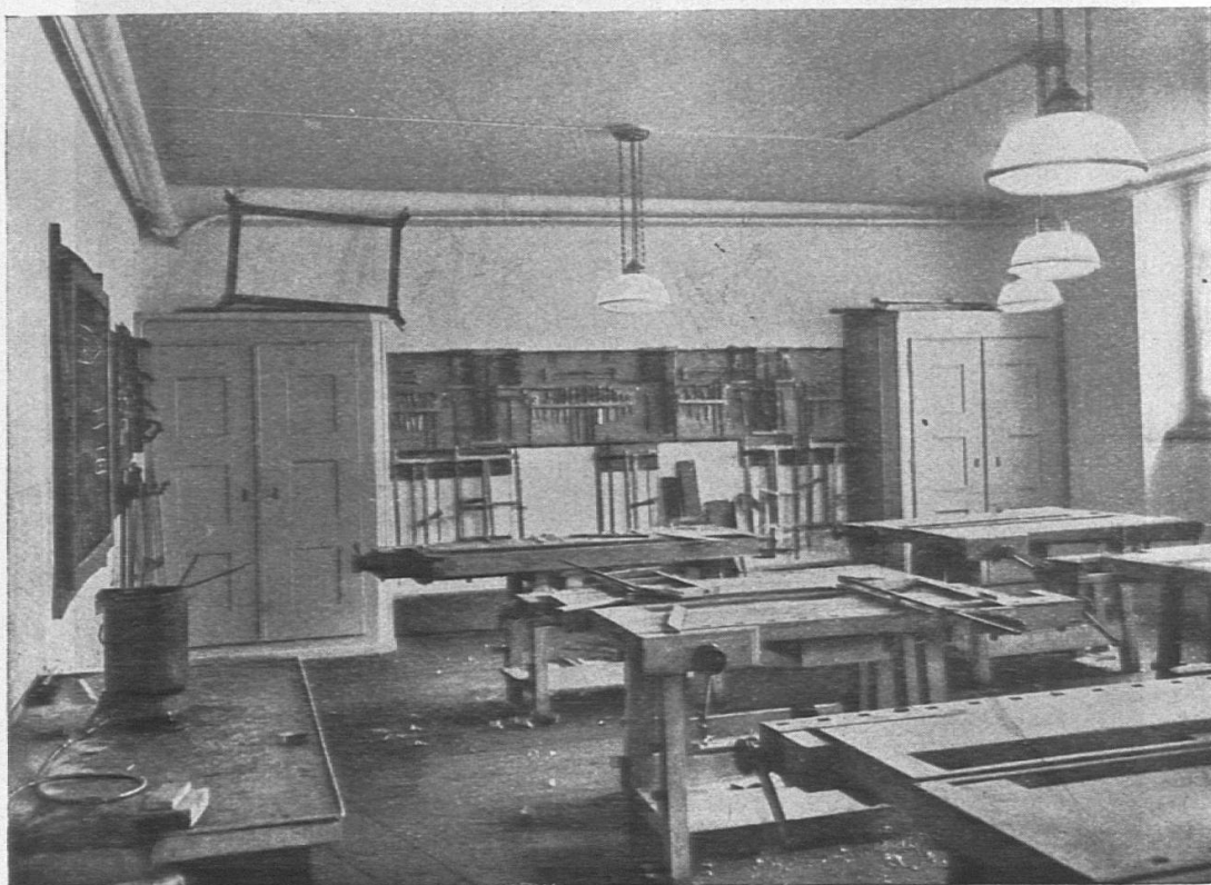
Primarschulhaus Breitfeld Bern. Handarbeitsraum.
