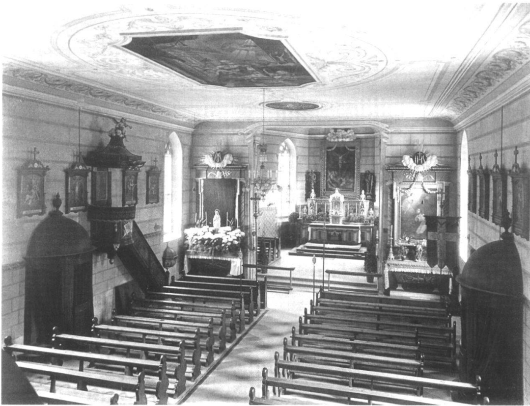
Abb. 10 Inneres der Pfarrkirche vor der Totalrenovation von 1951
