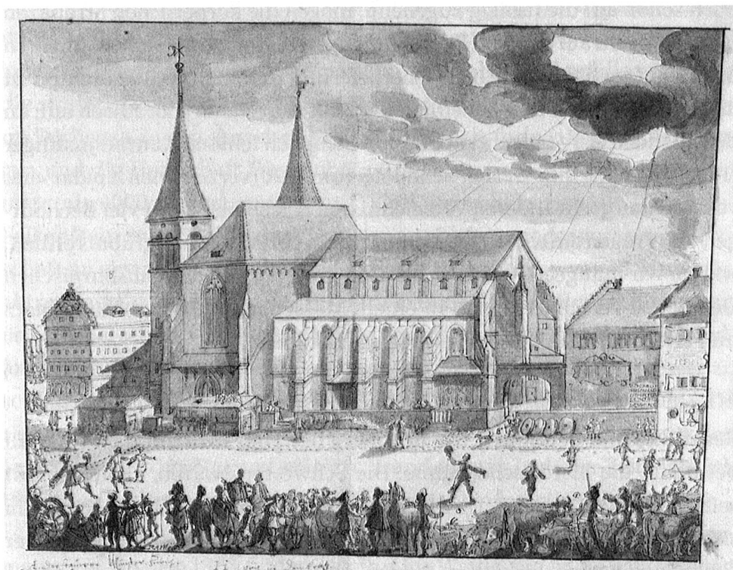
Abb. 4. Das Fraumünster im spätmittelalterlichen Zustand, von Norden. Die Schwestern Bechburg dürften das Langhaus der Kirche, das später als das Querhaus mit geringerer Firsthöhe errichtet wurde, noch als Baustelle gesehen haben. Lavierte Federzeichnung von Rudolf Meyer, um 1636.
