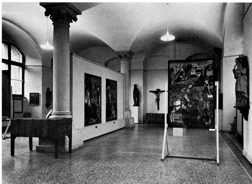
7. Raum 2a. Zustand vor dem Umbau (S. 12)
