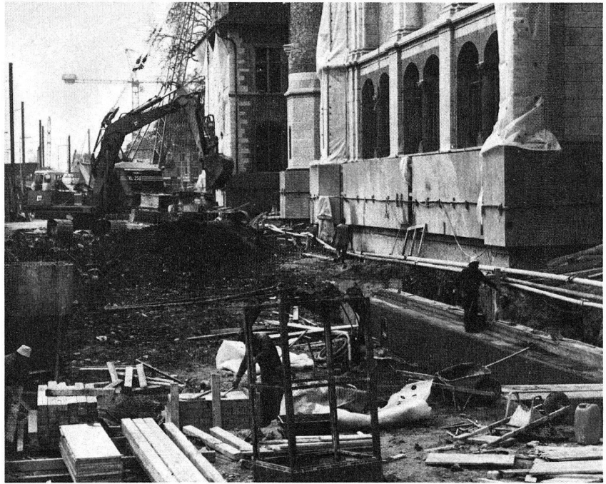
71. Blick auf die Baugrube an der Museumstrasse. (S. 62)
