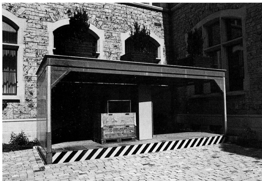
Abb. 100. Im Hof des Landesmuseums neuin- gebauter Transportlift für schwere Lasten. (S. 82)
