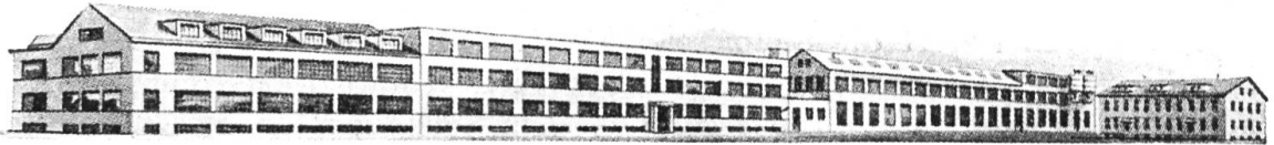
Gesamtansicht der Brac AG. Breitenbach.
