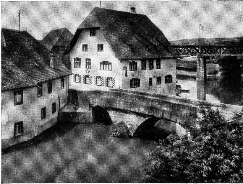
Die Brücke von Augst
