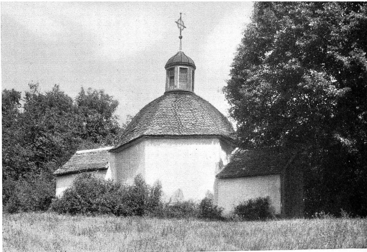
Die St. Annakapelle vor der Restauration
