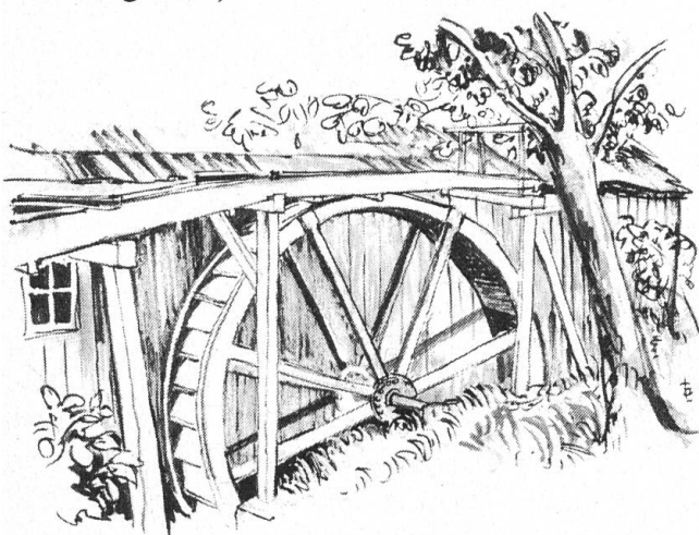
Seewen: Wasserrad der Sägerei Trummer. Schon zweimal wurden Reparaturkosten durch den HS übernommen, doch hat ein Hangrutsch die Wasserzufuhr blockiert.
