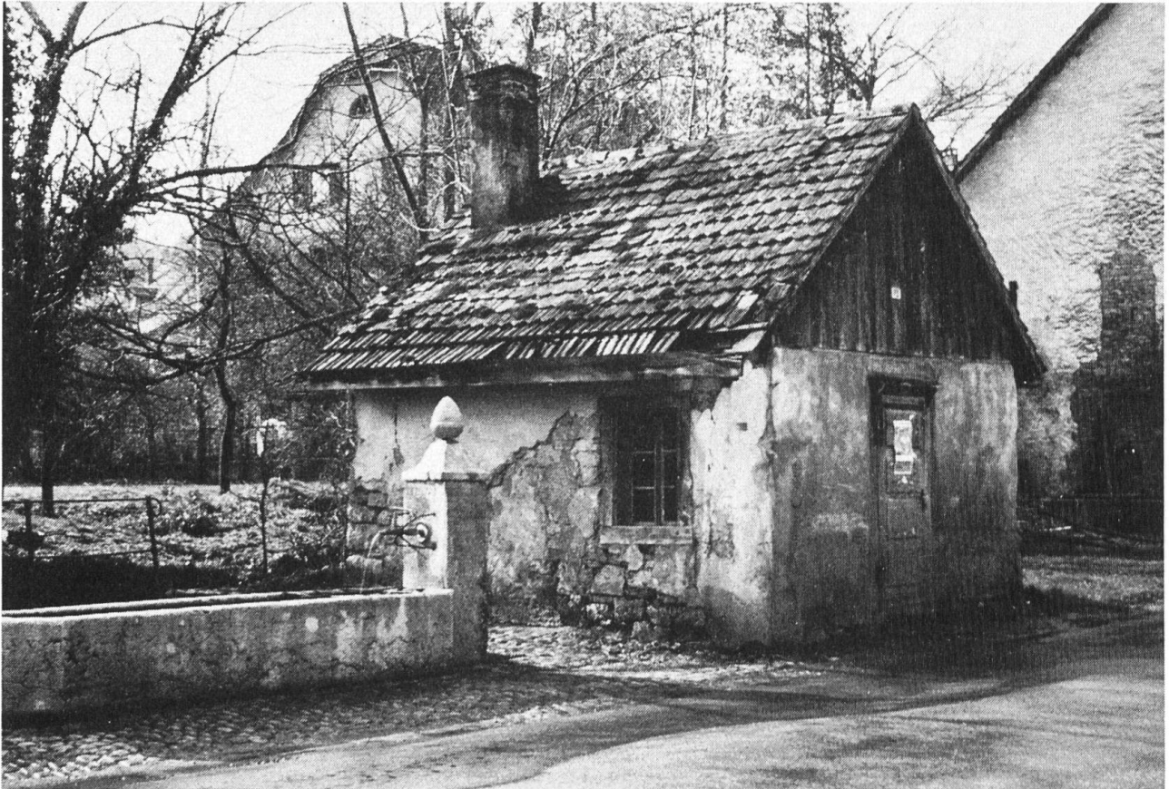
Buchhüsli im Unterdorf, vor der Renovation 1979.
