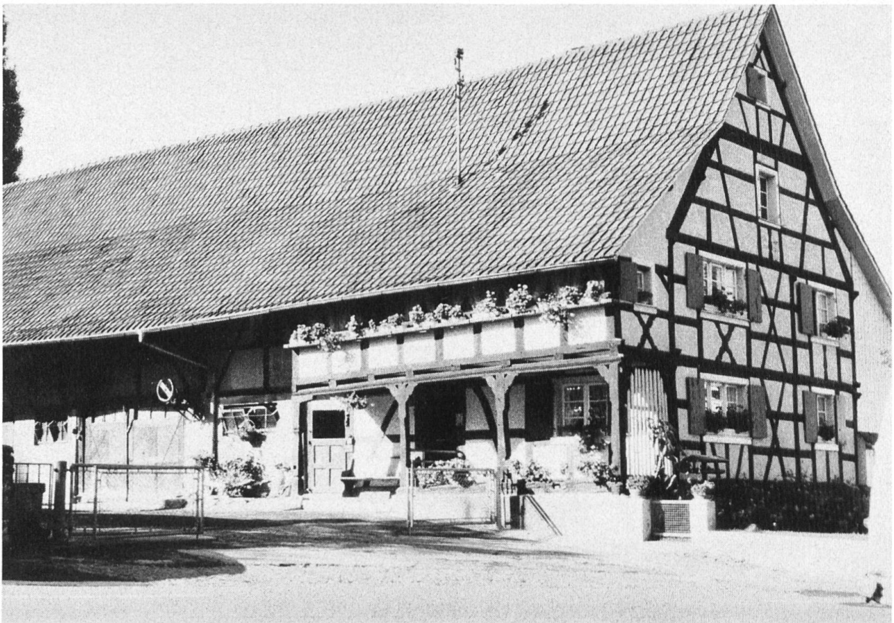
Haus Nr. 24 an der Oberwilerstrasse.
