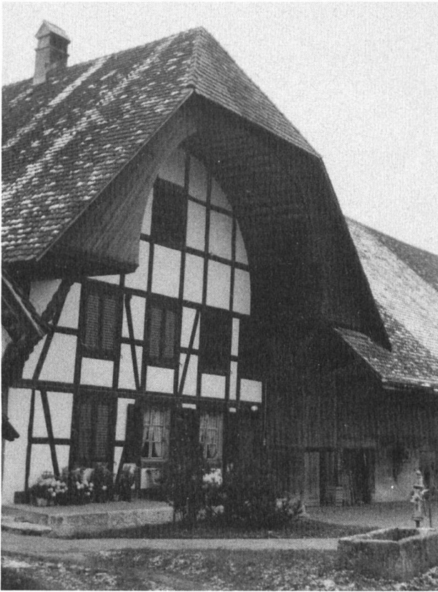
Rechts: Der Buchhof, Ammannsegg. Nordfassade des Hauptgebäudes. (Foto Denkmalpflege)
