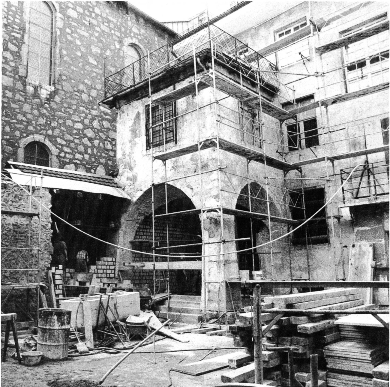
Der Innenhof während den Umbauarbeiten mit dem 1787 angebauten «Turm».
