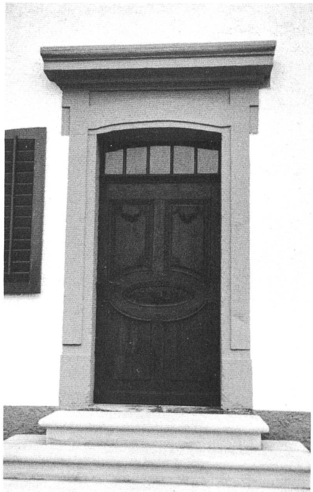
Türe im Peier-Haus, Obergösgen; die Restaurierung wurde vom Heimatschutz subventioniert.
