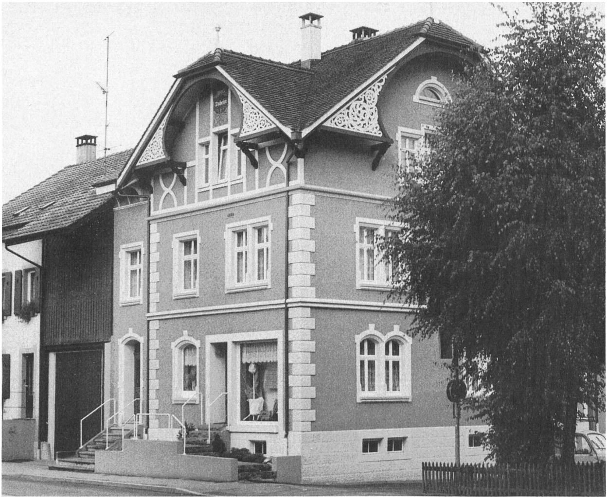
Bottmingen, Haus Therwilerstrasse 8, erbaut 1905.
