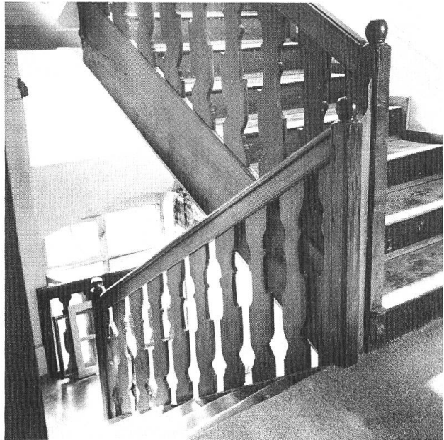
18 Die Treppenanlage von 1799.
