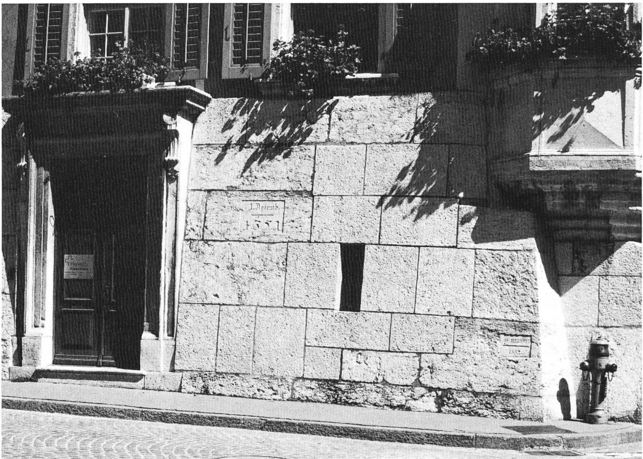
Hochwassermarken am ehemaligen Zunfthaus der Schiffsleute an der Schaalgasse. Links oben vom 1. Dezember 1651, rechts unten vom 18. Herbstmonat 1852. Foto: Denkmalpflege, Solothurn.
