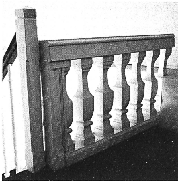
6 Balustradengeländer aus Eichenholz, wahrscheinlich Rest der Emporenbrüstung von 1706/09.
