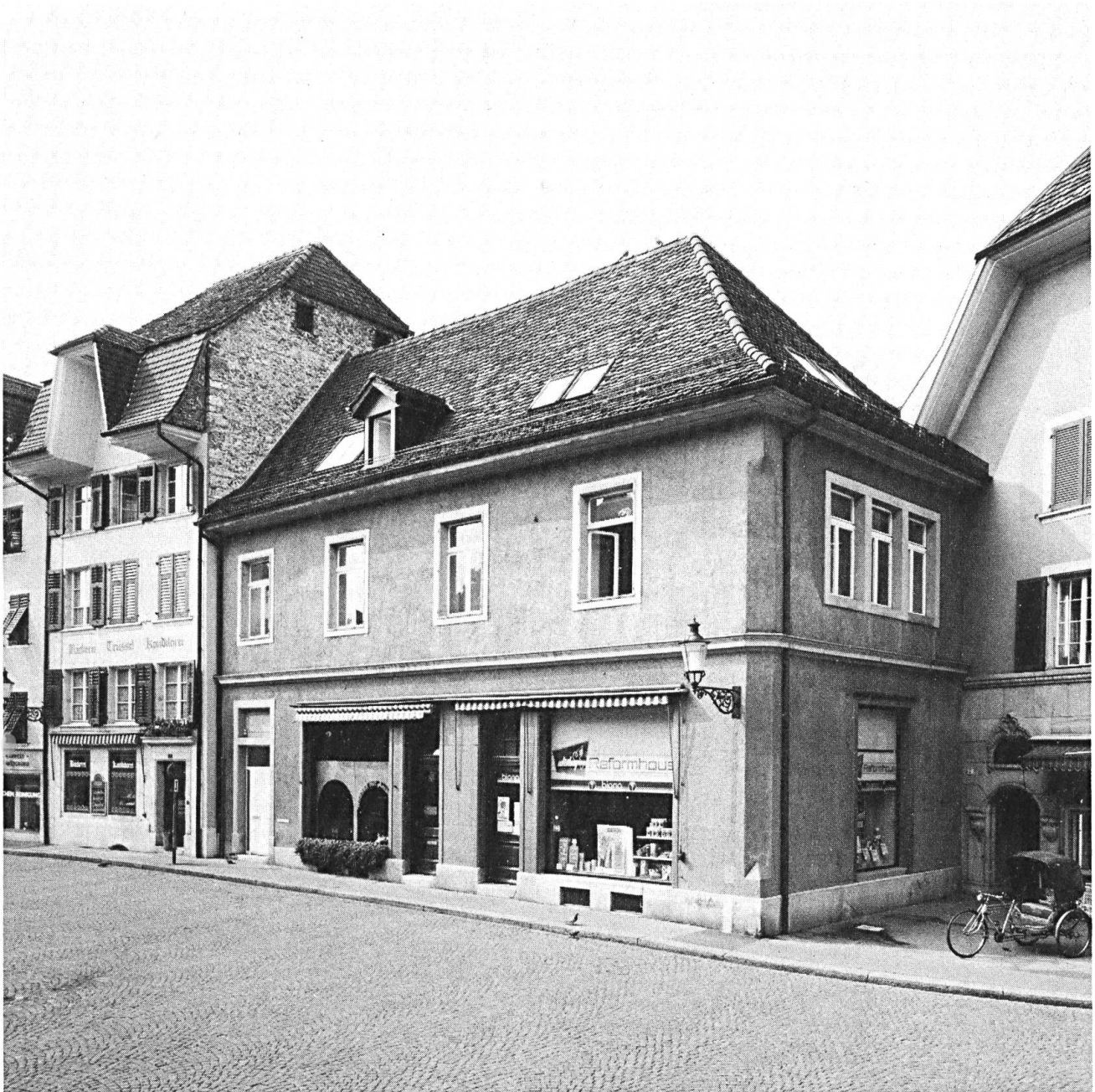
2 Die einstige Stephanskapelle, wie sie sich heute präsentiert. Fotografie von Pascal Hegner, Frühjahr 1984. Die Schaufensteranlage im Erdgeschoss entstand 1920, das Dreierfenster nach Osten im 1. Stock 1959 und die Dachfenster 1961.
