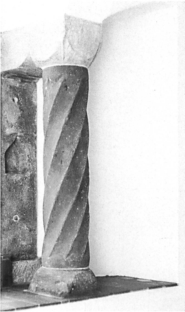
Diegten: Neuentdeckte spätgotische Säule in der ehemaligen Wirtsstube des Restaurants Wyburg, 16. Jahrhundert.
