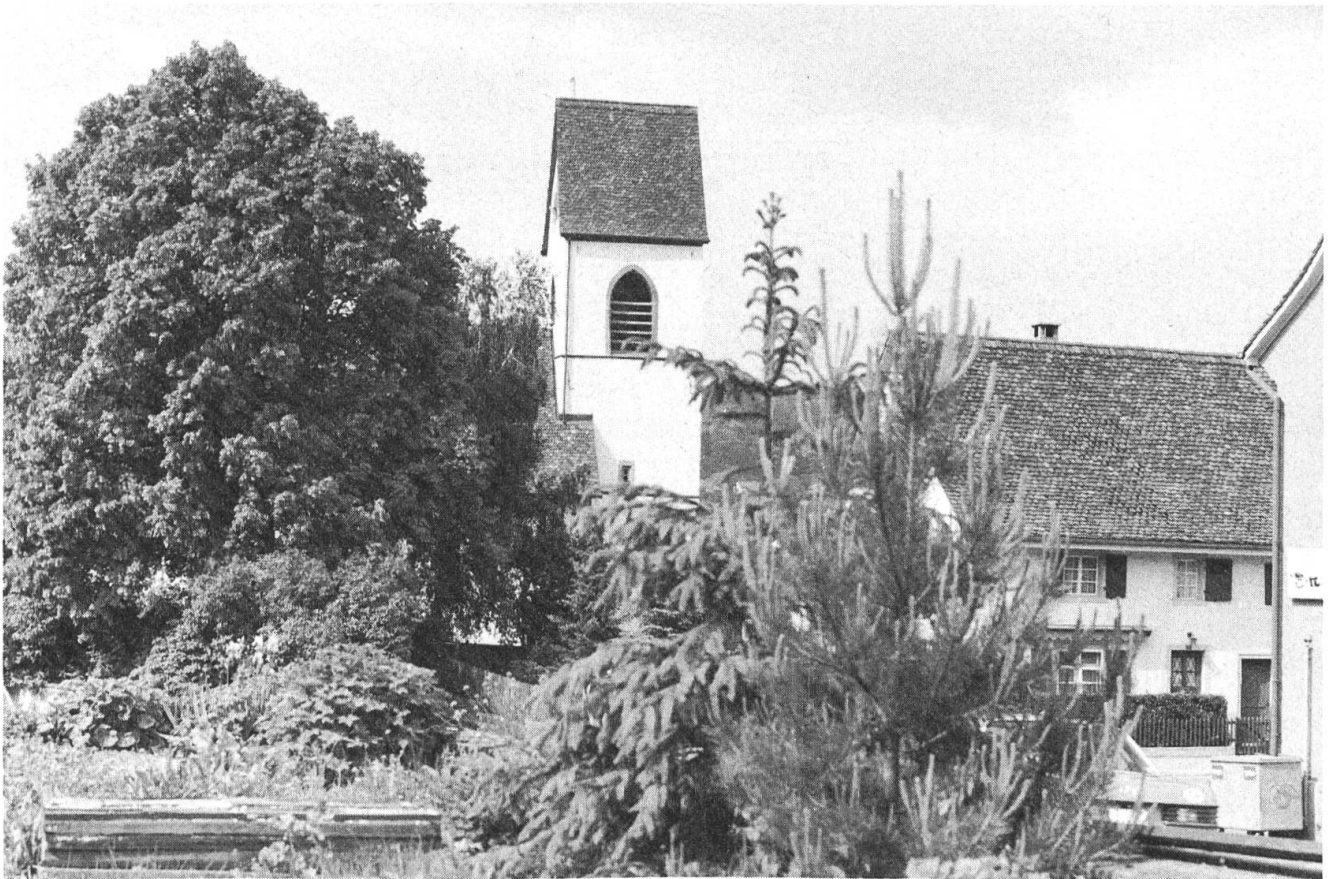
Biel-Benken. Blick gegen Westen. (Foto: Kuno Mathis, Binningen)
