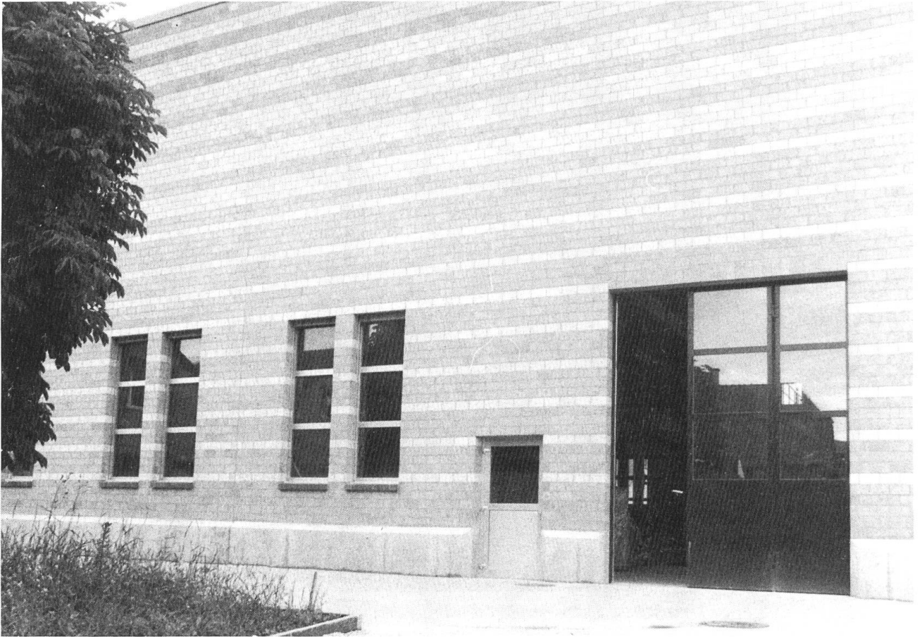
Anbau Bodenplattenfabrik in Laufen, System Einbrand von 1990 von Architekt Giuseppe Gerster.
