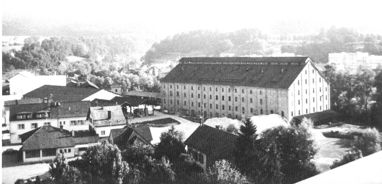
Werk 3 kurz vor dem Abbruch von 1978. Aufnahme Archiv Gerster Architekten, Laufen.
