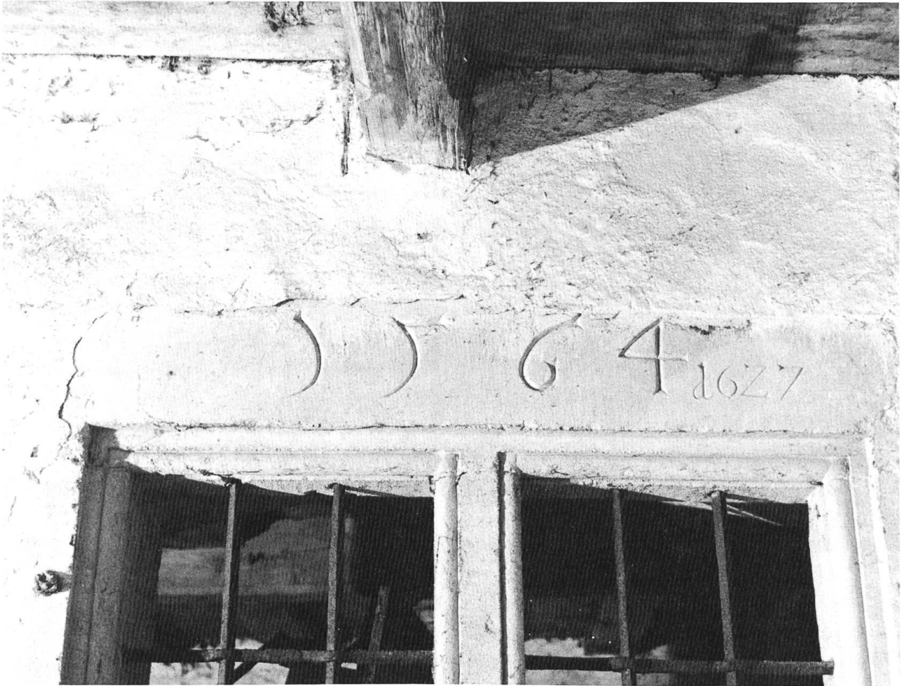
3 Die Baudaten 1564 und 1627 am westseitigen Fenstersturz im Obergeschoss.
