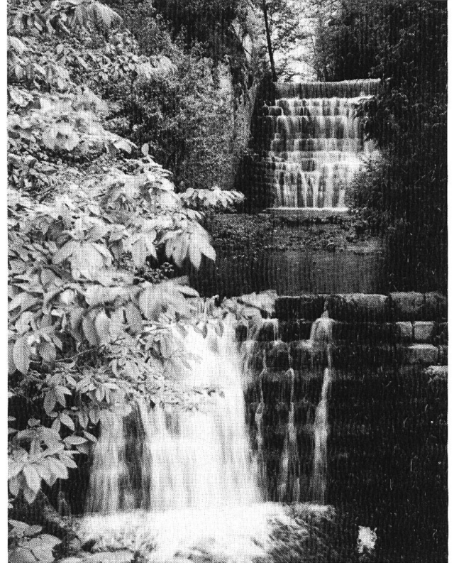
Um den Wildbach zu bändigen, hat man am Hammerrain Schwellen und Stufen eingebaut. In der Nähe des Hofes Hinterer Hammer westlich Herbetwil ist ein Wasserfall entstanden. Foto Peter Hagmann
