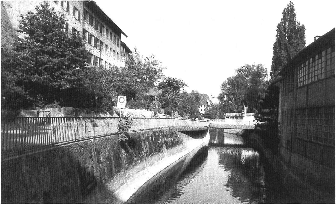
Die heutige Beton-Dünnernmündung zwischen Altstadt und Schwimmbad Olten. Foto Peter Hagmann
