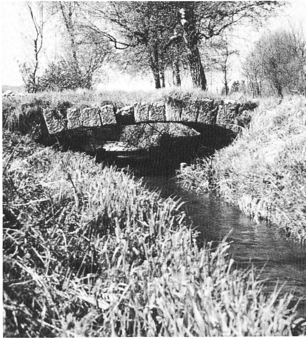
Vor der Korrektur war das Gäu von zahlreichen Gräben durchzogen wie hier zwischen Neuendorf und Härkingen. Foto Urs Wiesli
