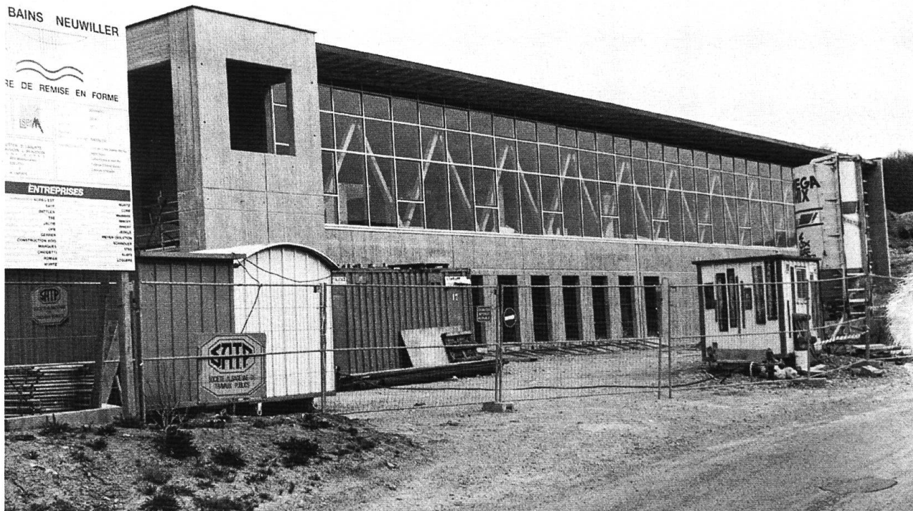
Das neue Bad ist im Bau.
