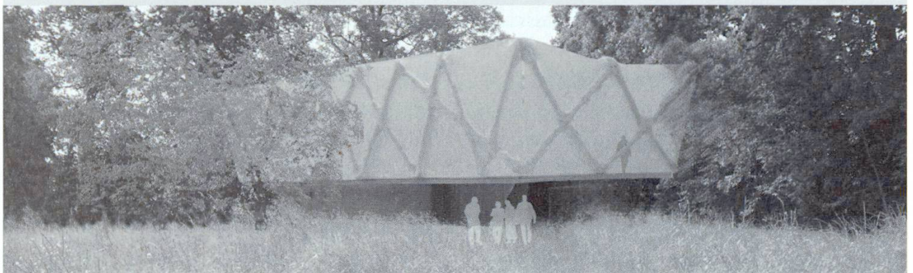
Marcel Hohl; Konstruktion PVC-Rohre mit Spritzbeton
