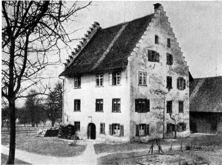
Schloß Hüttlingen. Außenansicht. Jetziger Zustand
