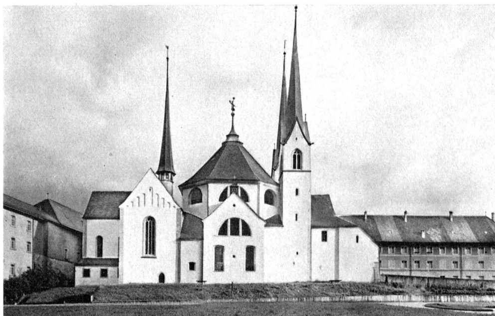
MURI: 1957 RESTAURIERT, 1960 VERBAUT?
