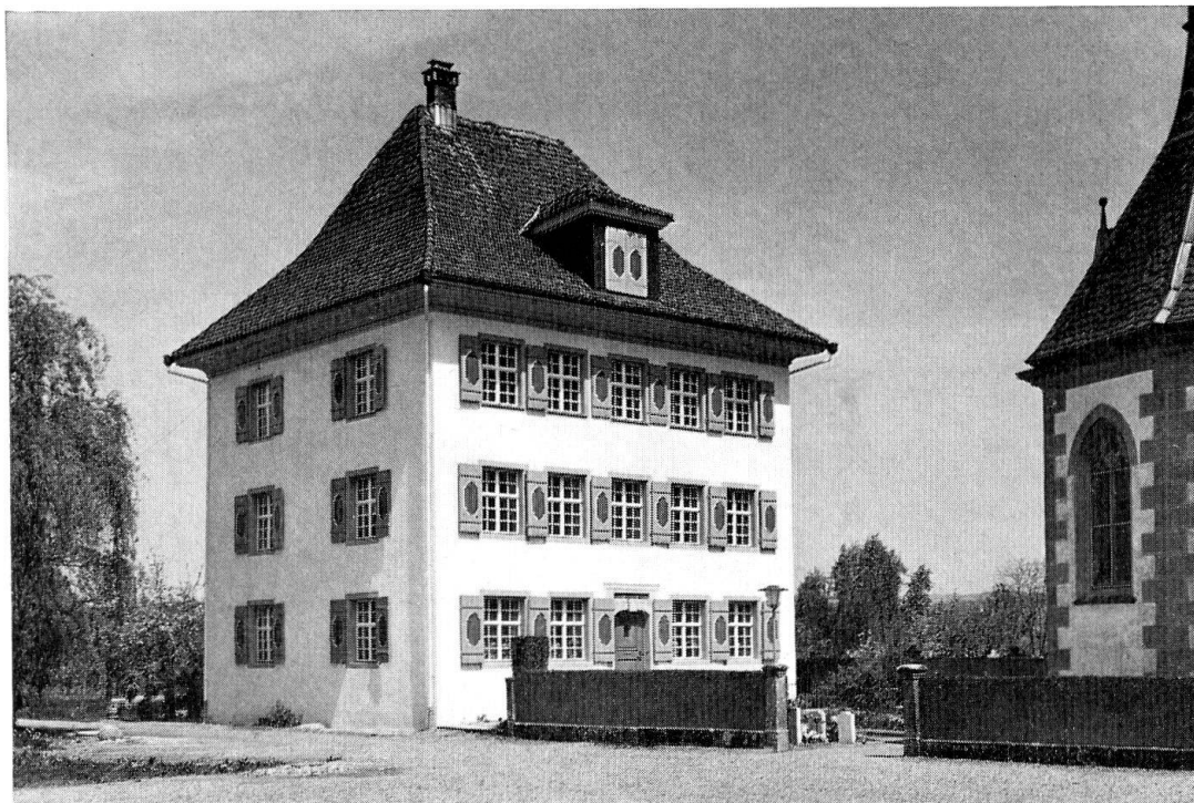
Merenschwand. Kaplanei nach der Restauration von 1962/63
