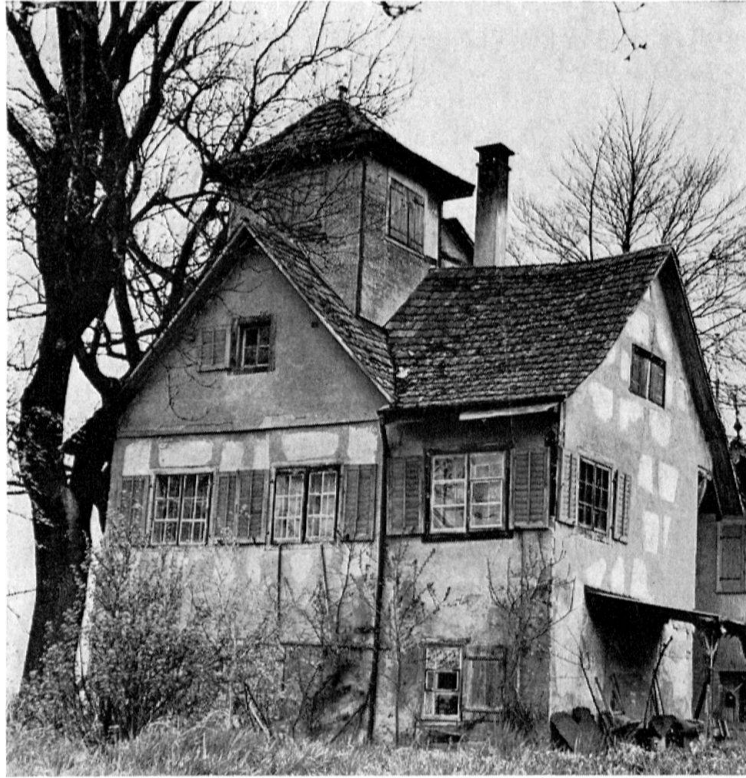
«Guggenhürli», Frauenfeld. Vor der Restauration
