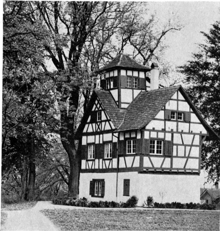
«Guggenhürli», Frauenfeld. Nach der Restauration
