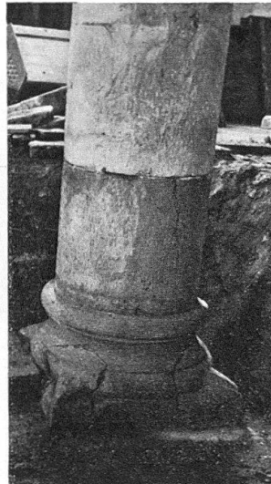
Abb. 7. Feldbach. Säulenbasis, durch Erdbeben zerbrochen
