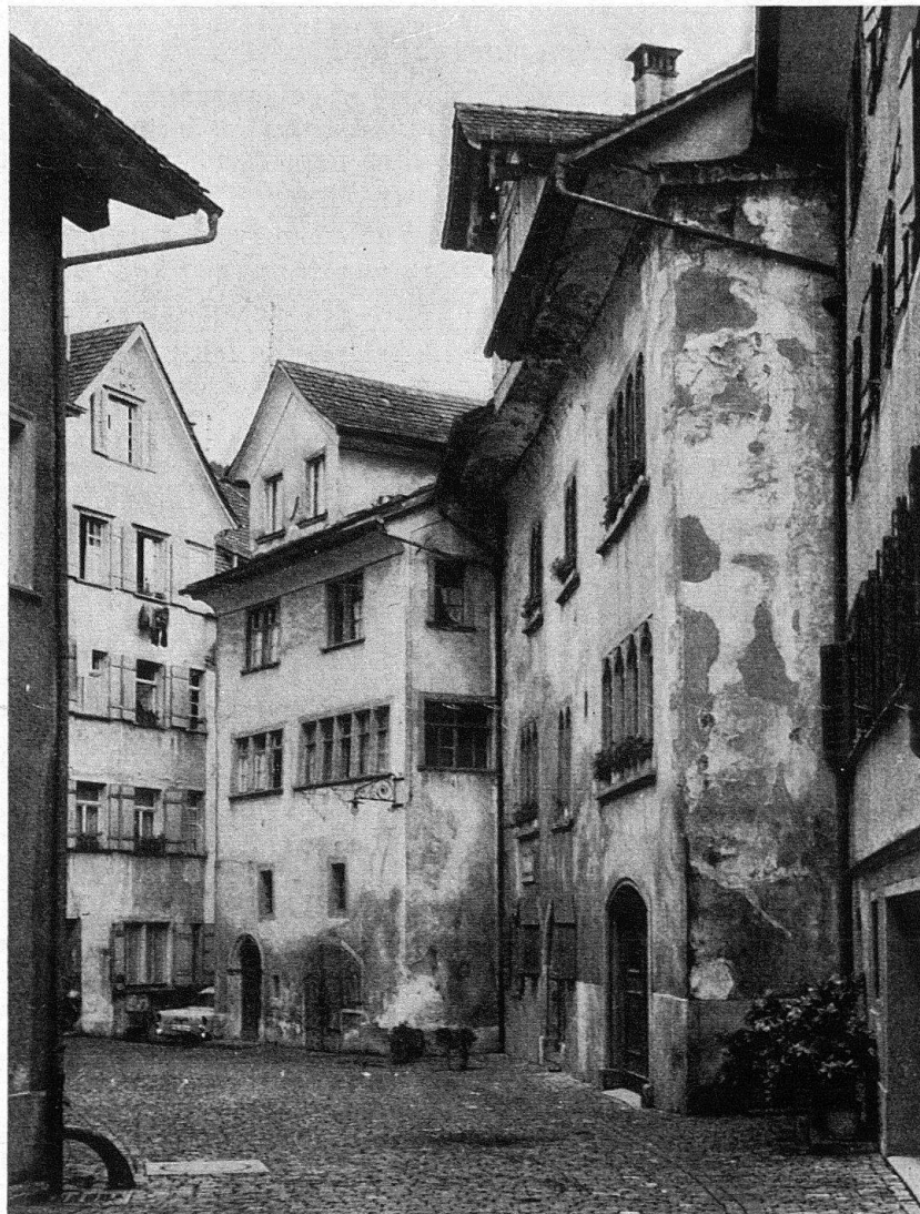
Abb. 1. Lichtensteig. Altes Rathaus, Zustand vor der Restaurierung
