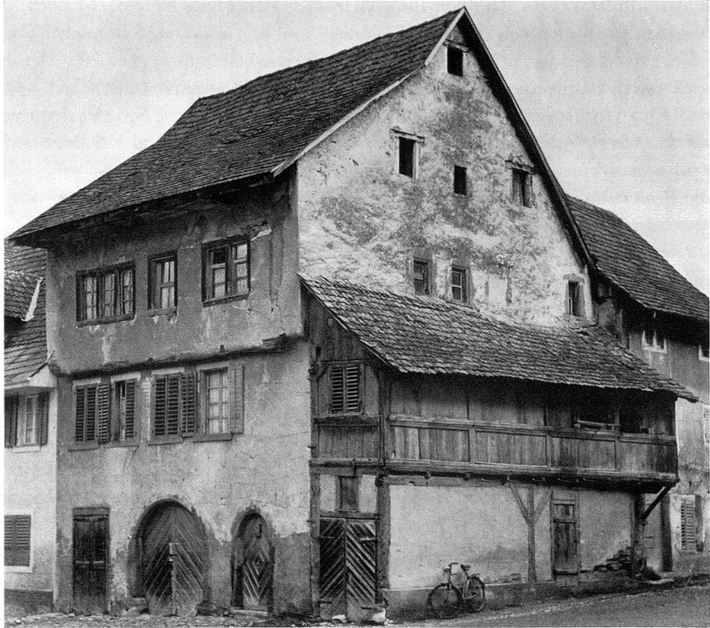
Abb. 1. Zurzach, Haus «zum Elefanten», Ansicht von Südwesten, 1966.
