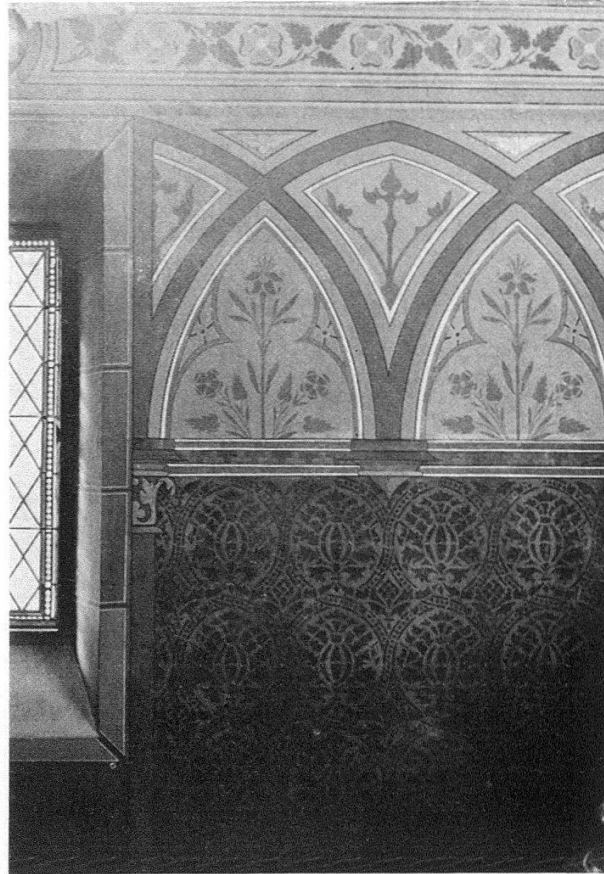
Abb. 9. Dußnang TG, Katholische Pfarrkirche. Detail der Wandmalereien
