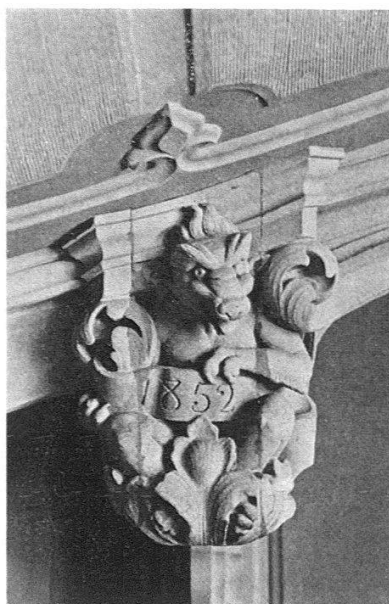
Abb. 6. Schloß Schadau. Schlußstein im Treppenhaus von Josef Hubert Verbunt
