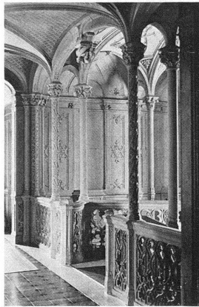
Abb. 4. Schloß Schadau. Korridor und Treppenhaus im Obergeschoß
