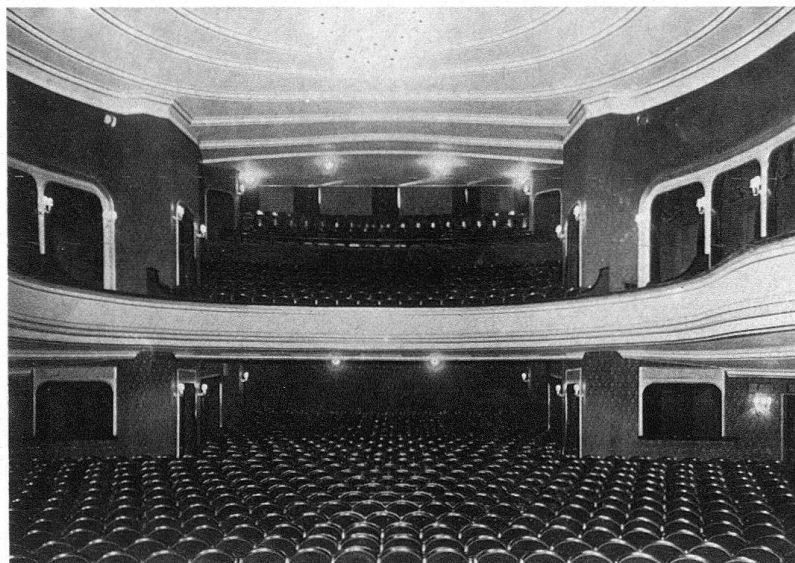
Abb. 8. Das Innere des Pfäuentheaters, nunmehr «Schauspielhaus», in Zürich, nach dem Umbau von Otto Pflughard d. Ä. (1869–1958) im Jahre 1926
