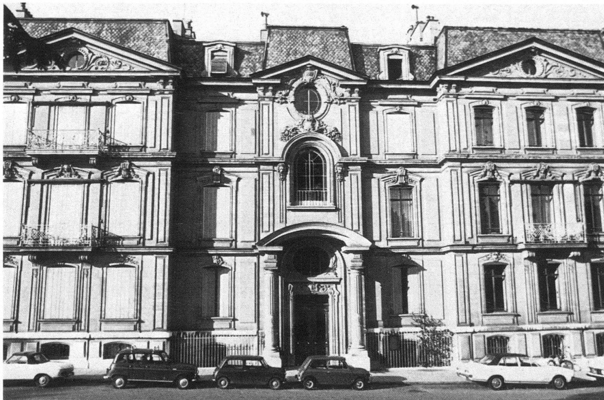
1 et 3 promenade du Pin: L'architecte Jacques-Louis Brocher s'inspire de François Mansard. Les deux maisons sont unies par un axe de symétrie unique marqué par une entrée monumentale
