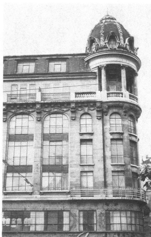
Fig. 6. Immeuble «Ausoni», 1912/1913 à l'entrée de la rue du Marché (demande de démolition 1976)
