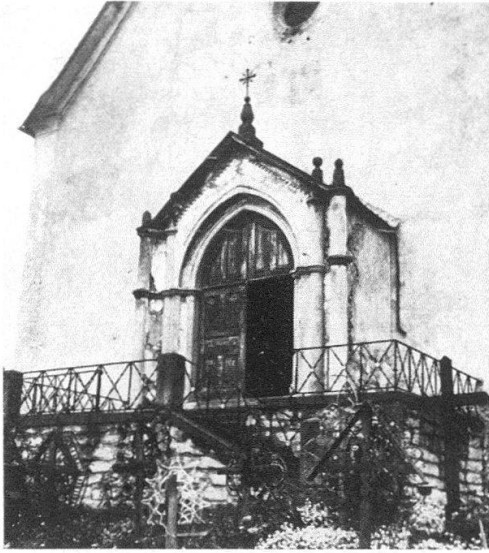
Abb. 7. Portal, um 1964, vor der Restaurierung
