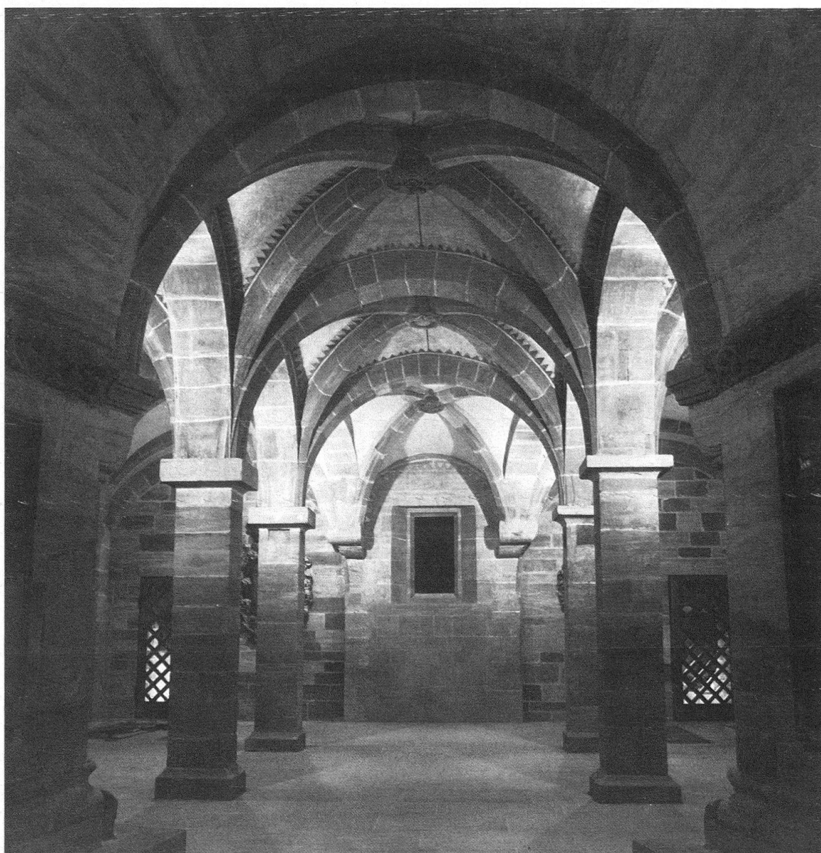
Basel, Krypta des Münsters. Zustand nach der Restaurierung von 1975
