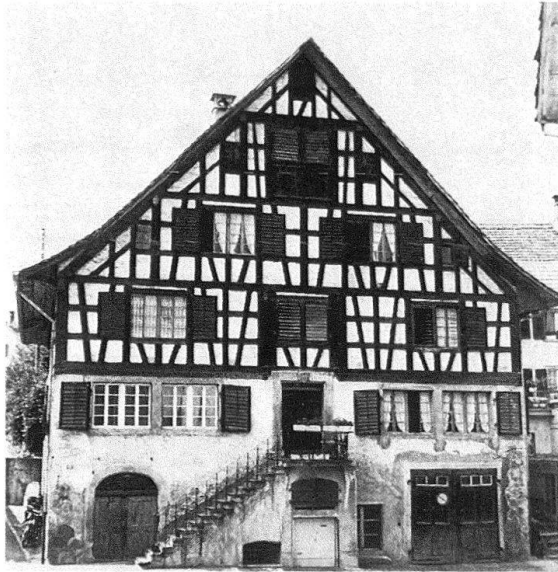
Richterswil ZH. Gemeindehaus «Bären». Oben links vor, rechts nach der Restaurierung. Die Treppe und das rechte Portal wurden nach einer alten Photo (unten links), die Malerei an den Klappläden nach Befund rekonstruiert (unten Mitte originale, rechts erneuerte Bemalung)
